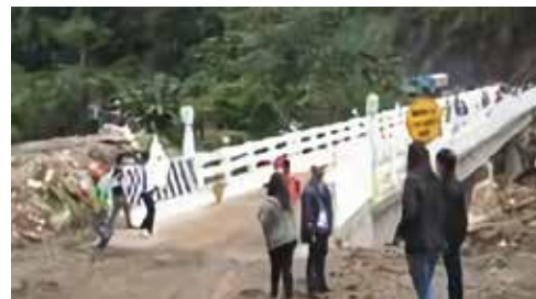
Ammoweg RCDG Bridge in Brgy Ammoweg, Ambaguio, Nueva Vizcaya
