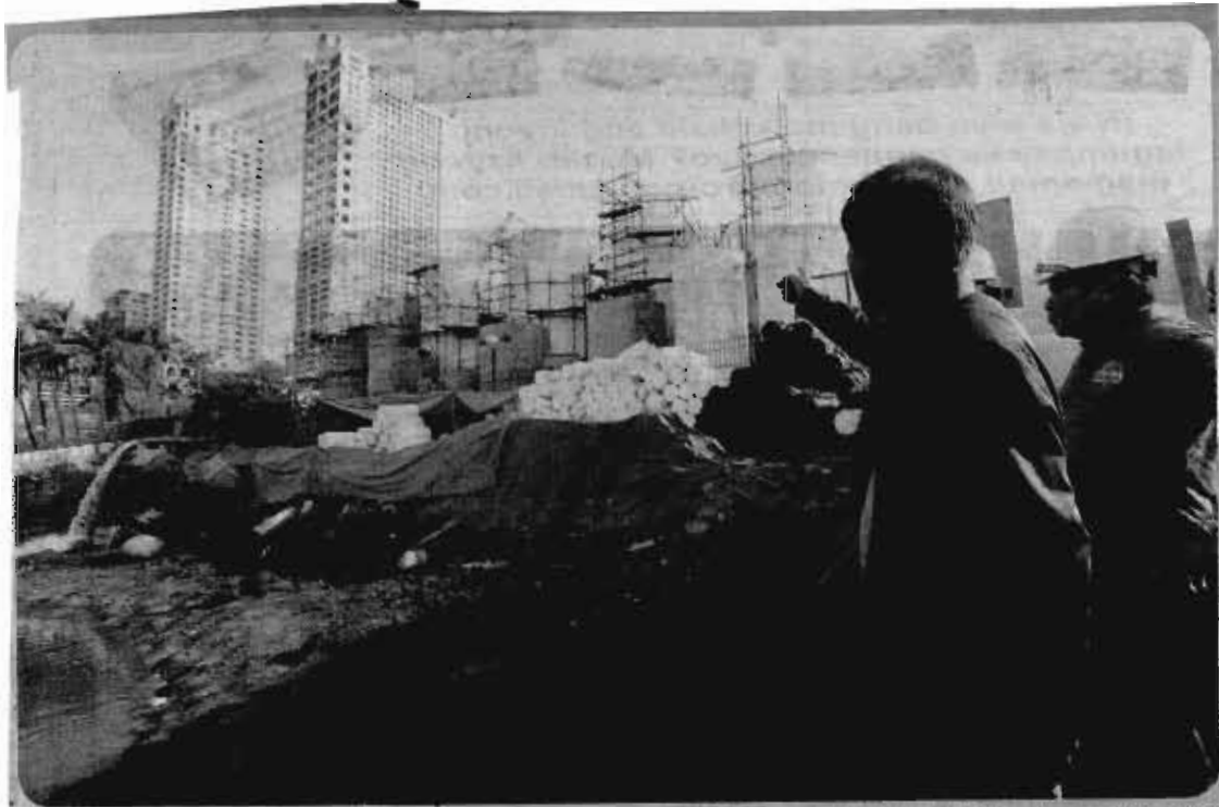
SEWAGE TREATMENT PLANT. Inilnspeksiyon nina Department of Environment and Natural Resources (DENR) Secretary Roy Cimatu at Metropolitan Manila Development Authority (MMDA) chairman Danny Lim ang nagpapatuloy na konstruksiyon ng Sewage Treatment Plant sa kahabaan ng Roxas Boulevard sa Maynila. Ang konstruksiyon ng treatment plant ay bahagi ng programa ng pamahalaan na inilunsad noong nakaraang taon para linisin, i-rehabilitate, at pangalagaan ang Manila Bay. PNA photo by Oliver Marquez
