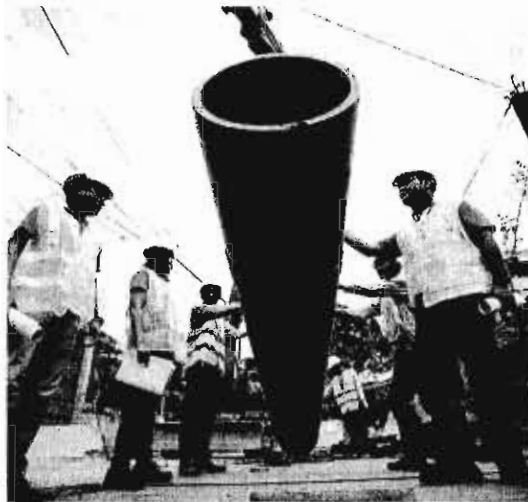
Ang paglalatag ng bagong sewer lines ay kailangan para mapalawak ang sewerage coverage ng Maynilad sa West Zone concession.
