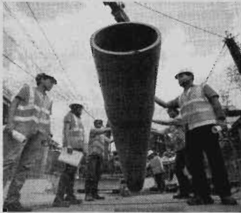
Ang paglalagat ng bagong sewer lines ay kailangan para mapalawak ang sewerage coverage ng Maynilad sa West Zone concession.
