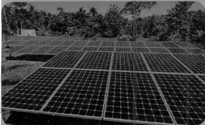
MAKIKITA sa larawan ang 32kW solar panel microgrid na nagsupply ng koryente sa Isla Verde, Batangas.
