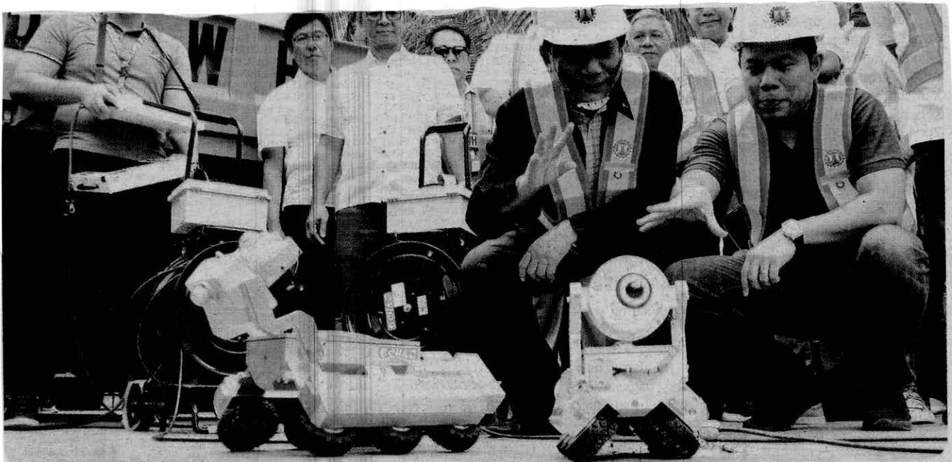
SINISIYASAT nina DENR Secretary Roy Cimatu at DPWH Secretary Mark Villar ang dalawang remote camera na gagamitin sa pag-detect ng basura sa loob ng imburnal sa pagsisimula ng desilting at dredging ng 100 metro sa seawall ng Manila Bay sa pagitan ng US Embassy at ng Manila Yacht Club. Kuha ni NORMAN ARAGA
