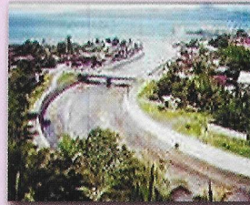
Flood Control System sa Ormoc City
